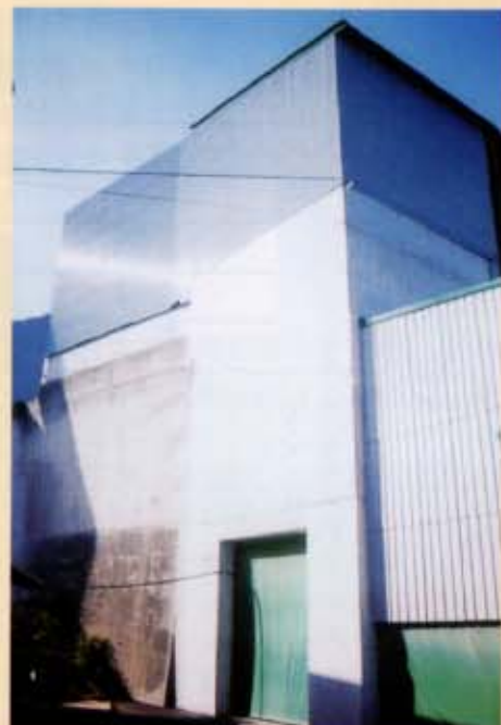
破碎、選鉱プラントを建家で囲い粉じんの拡散を防いだ。
