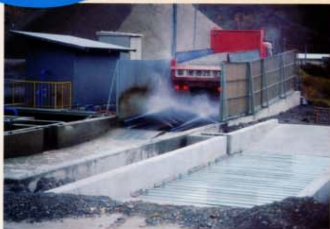
切羽から出る車両を自動洗浄機で洗車し、粉じんの発生を抑えた。
