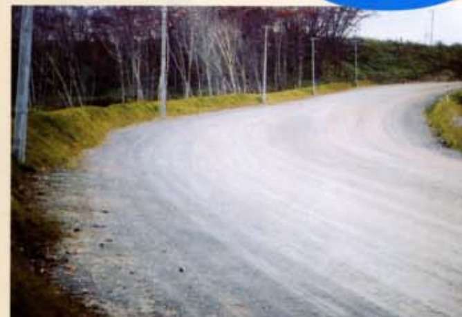
鉱山道路の幅員を広げるとともに路肩を盛土し道路の境界を明確にした。
