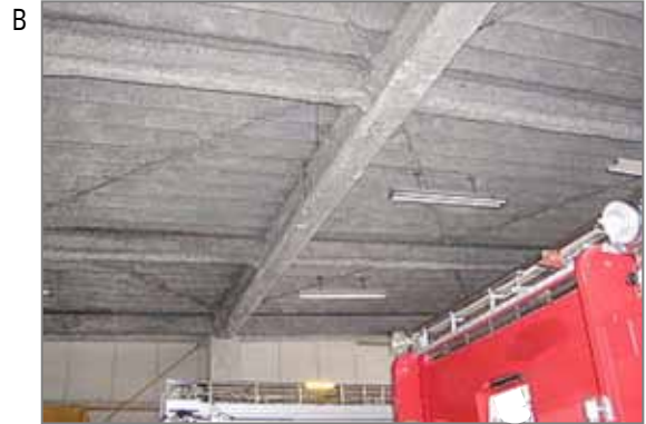
消防署自体の建物も車庫などには耐火吹きつけ、張りつけ材などがあります。劣化や破損によりばく露の可能性があります。
