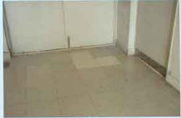
石綿含有ビニール床タイル（床）
