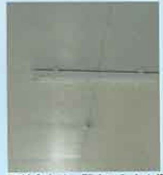
石綿含有けい酸カルシウム板 石綿スレート（天井）
