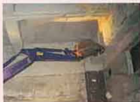
発泡ウレタン断熱材 (吹きつけ)
