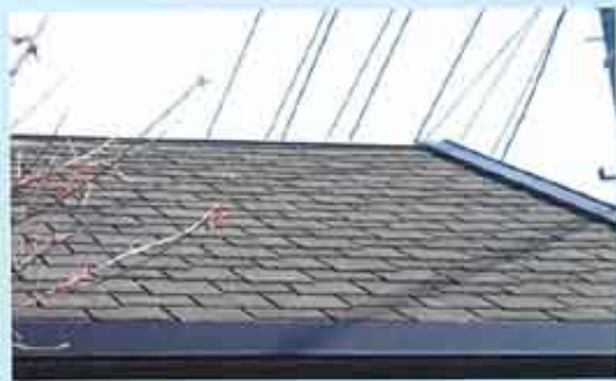
石綿含有住宅化粧用スレート（屋根）
