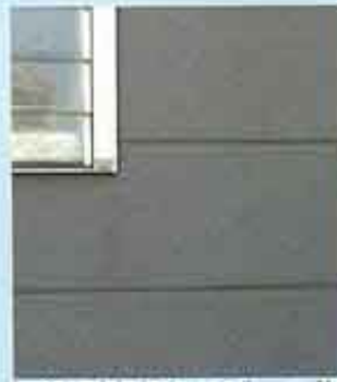
石綿板（商業系サイディング）
