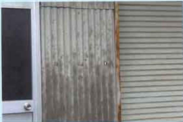
石綿スレート（屋根・外壁）
