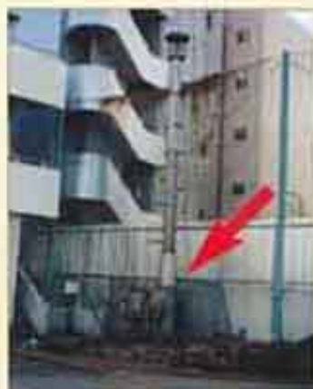
廃棄物焼却炉
