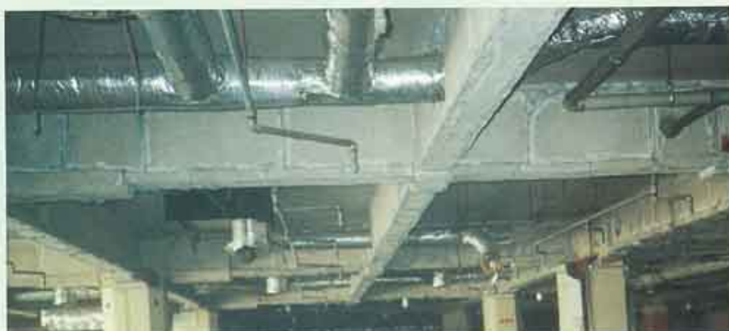
耐火被覆用石棉含有ケイ酸カルシウム板（2種）（S造の柱・梁）
