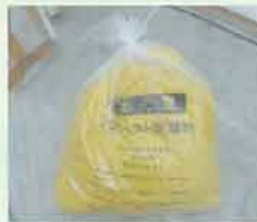
アスベスト廃棄物の二重袋詰
