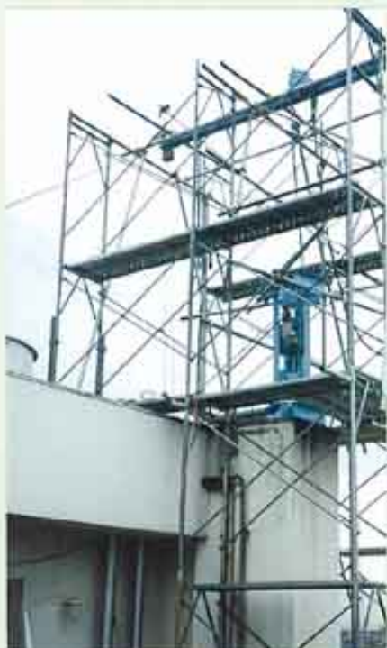
煙突上部及び灰出し口を隔離養生
