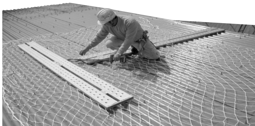
写真 踏み抜き防止用の安全ネットをスレート屋根上に敷き、歩み板を使用した補修工事の例 ((株)A社)
